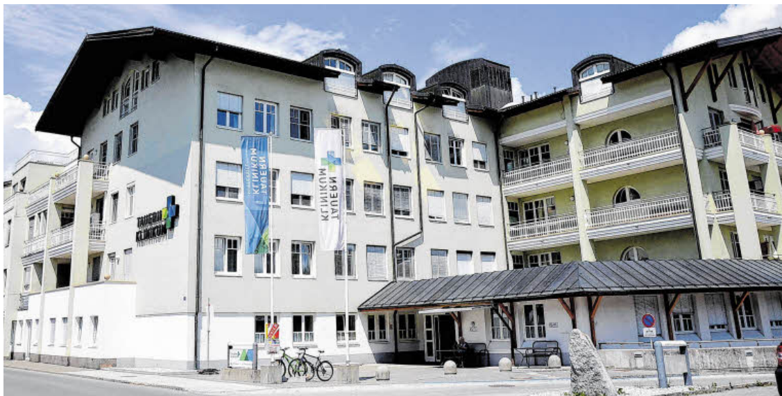
Das Mittersiller Krankenhaus wird ab April 2020 umgebaut.
