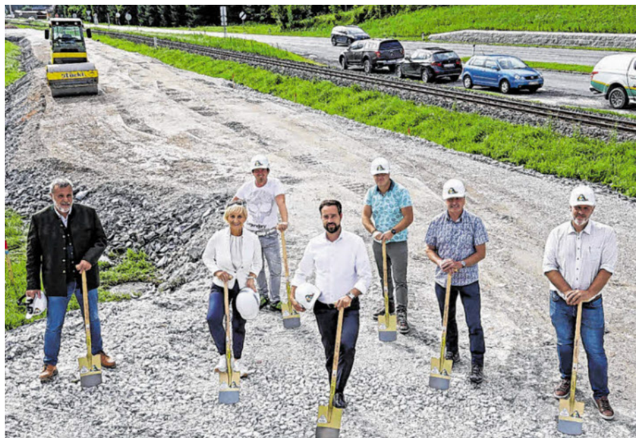
V. l.: Franz Stöckl (Stöckl Erdbau), Sonja Ottenbacher (Bgm. Stuhlfelden), Christian Lechner (Stöckl Erdbau), LR Stefan Schnöll, Jürgen Fuchs (Baucon), Sebastian Salchegger (Referat Straßenbau), Josef Voithofer (Amtsleiter).
