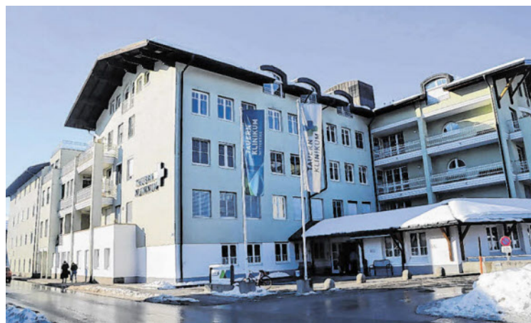
Auf dem Dach wird ein Hubschrauberlandeplatz errichtet.
