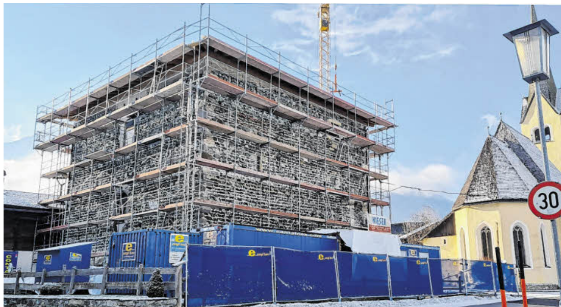
Der eingerüstete Felberturm. Rechts die Felberkirche.
